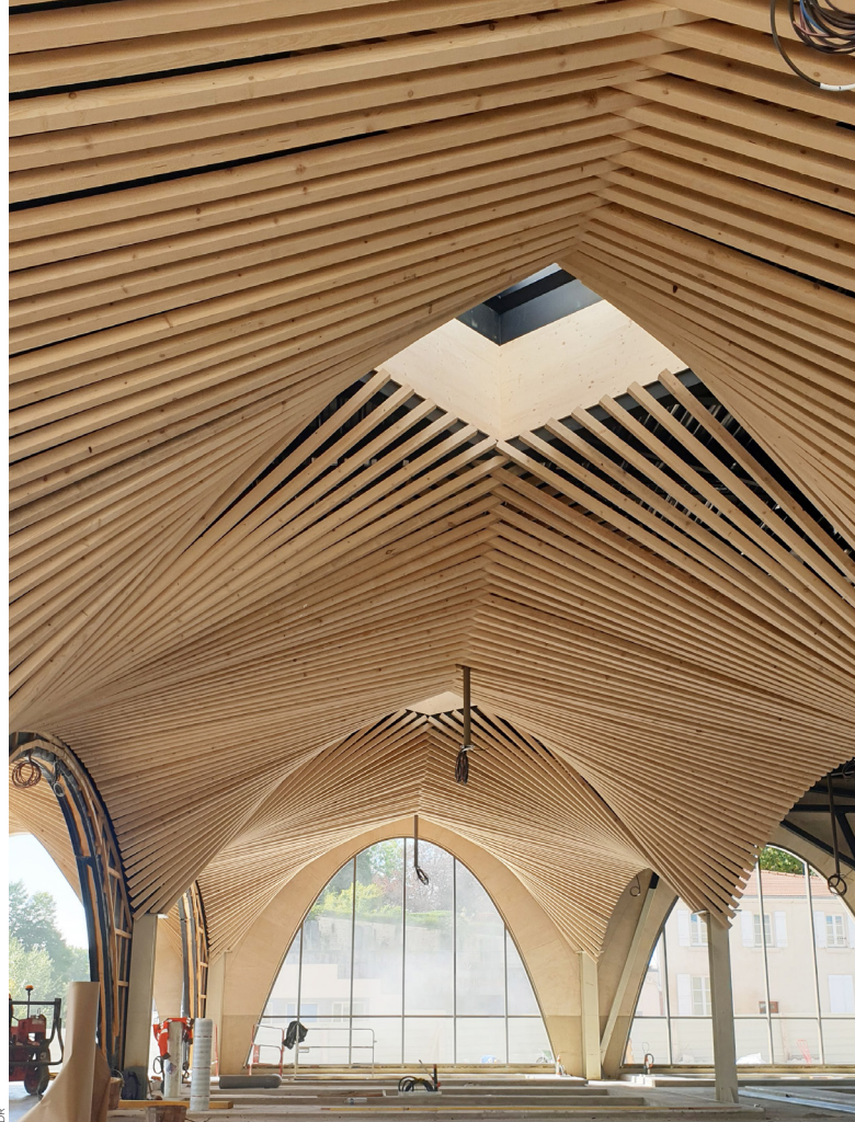
> Marché de Saint Dizier – chantier en cours Architectes : Christophe Aubertin et Aurélie Husson Résille bois en épicéa des Vosges
