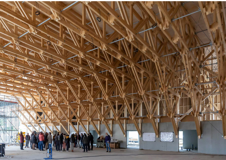
> Gymnase Jean-Lamour à Nancy - chantier en cours Architectes : Christophe Aubertin et Xavier Géant Charpente treillis en épicéa des Vosges
