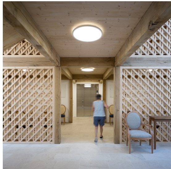
> Maison de santé de Liffol-le-Grand Architectes : Christophe Aubertin et Eleonore Nicolas Charpente poteau poutre en chêne du Jura et claustra en épicéa des Vosges
