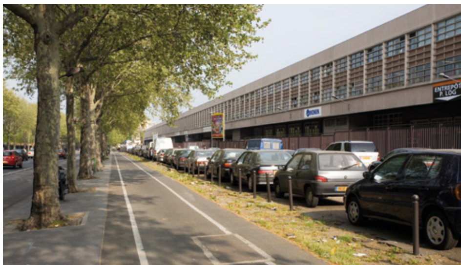
L'entrepôt Macdonald avant le début de sa réhabilitation.
